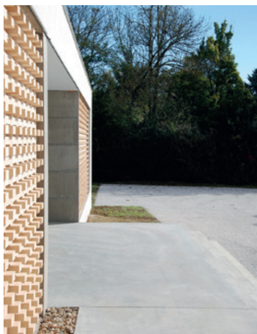
Détails des façades, vues sur les claustres de brique
